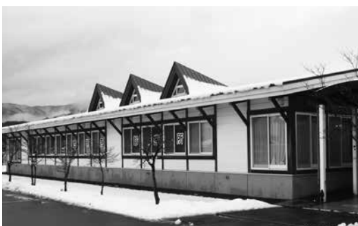
市川医師らの尽力で3倍の広さに建て替えられた診療所
