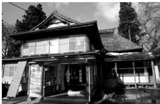
18世紀後半に建てられたとされる藤巻医院
