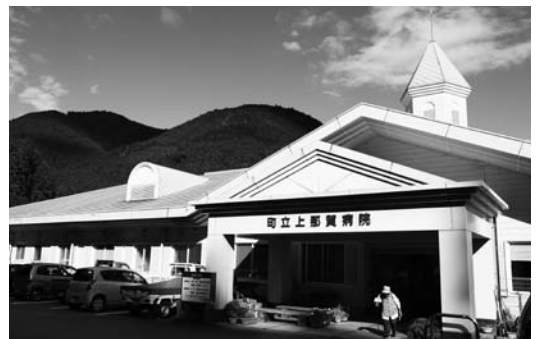
地元住民のよりどころである上那賀病院
