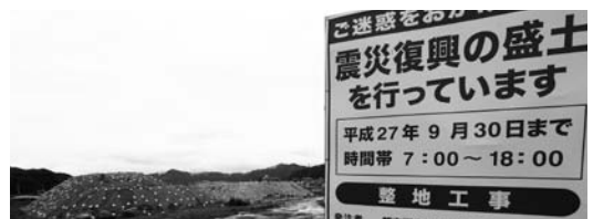
被災地では復興工事が進むが、工期を終えるにはまだ長い年月がかかる
